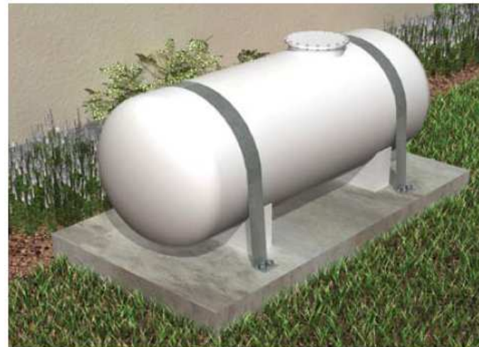
Renforcement du support et de l'ancrage de la cuve
