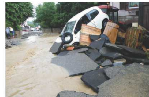
En bas de la rue d'Erlenbourg à Romanswiller, le revêtement de la voirie a été arraché et charrié par l'eau. PHOTO DNA - HERVÉ MICLO
