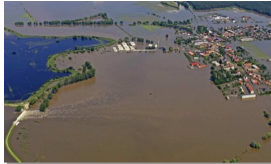
Inondations de l'Elbe à l'Est de l'Allemagne - rupture de digues (juin 2013)
