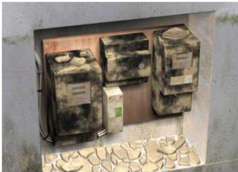
Dégradation d'un coffret de branchement extérieur
